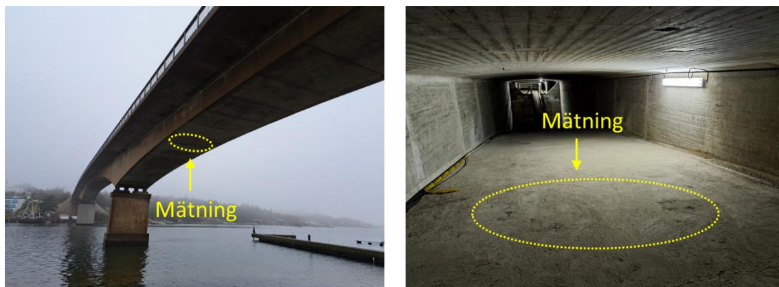
Figur 34. Foto på Stenungsöbron och plats för mätning.
